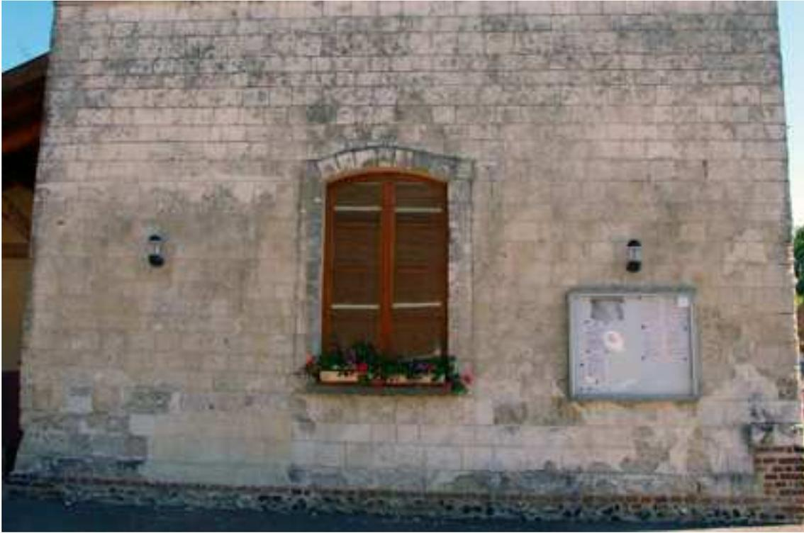
chaux, sable et produits hydrofuges) Les travaux consistent à un micro gommage léger sur le pignon, au remplacement des pierres trop poreuses qui seront découpées sur 4 cm de profondeur et remplacées par une pierre de même dimension et scellée au mortier chaux. Un chaulage de protection à base de chaux sera appliqué et un hydrofuge spécial pierre calcaire sera appliqué sur les 47m<sup>2</sup> de surface. La partie basse sera rejointée et une corniche, sur le
